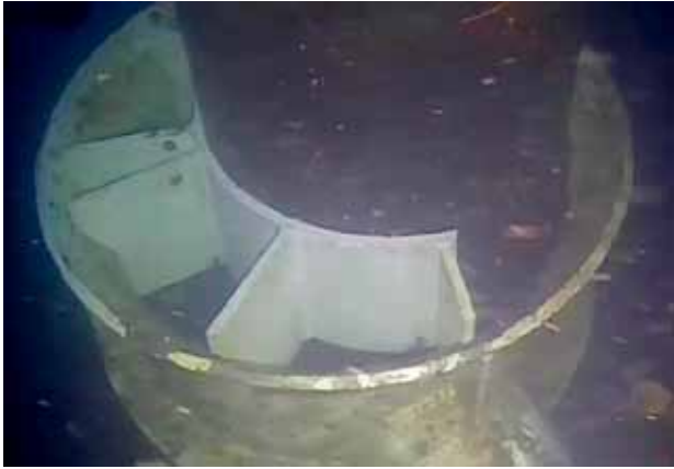
66米扶正块安装后图片
