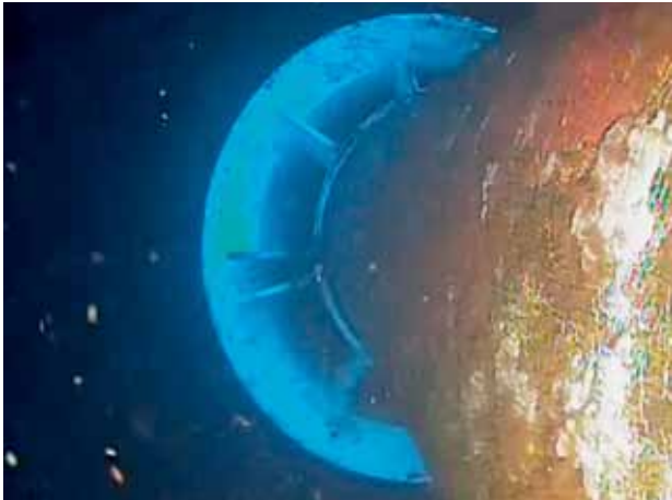
93米扶正块安装后图片
