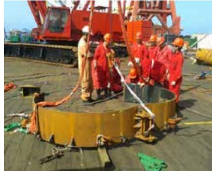
图8: 卡箍吊装下水示意
