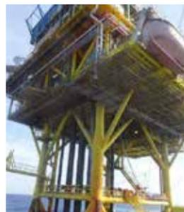
文昌13-1平台A1桩腿靠船件因受船舶撞击，造成靠船件水面与桩腿焊接位置结构开裂受损，水下结构连接法兰螺栓全部断裂，后期受台风的影响导致A1桩腿靠船件结构整体脱落缺失。油田作业公司出于安全生产的角度考虑，已进行新的靠船件预制，并委托德威胜对其A1桩腿靠船件进行安装。
